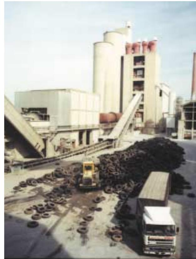
Altreifenanlieferung und Ofenbeschickung im Zementwerk
